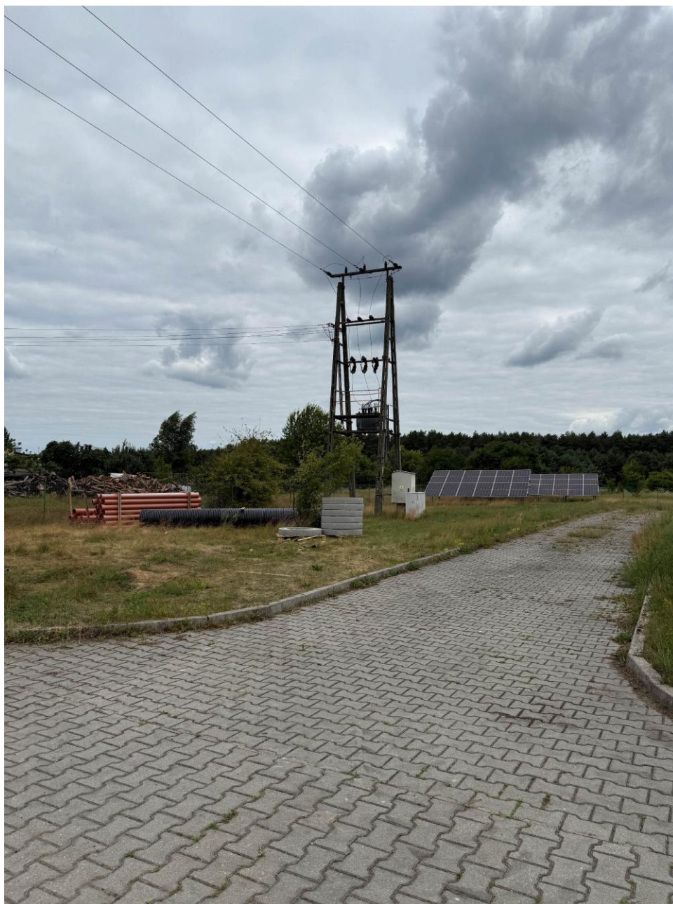
Zdjęcie 10 Trafostacja na słupie energetycznym i II część instalacji fotowoltaicznej.
