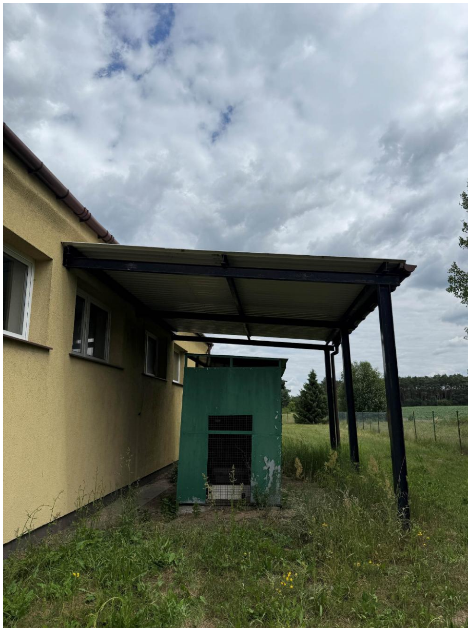
Zdjęcie 6 Istniejący agregat prądotwórczy z zadaszeniem.
